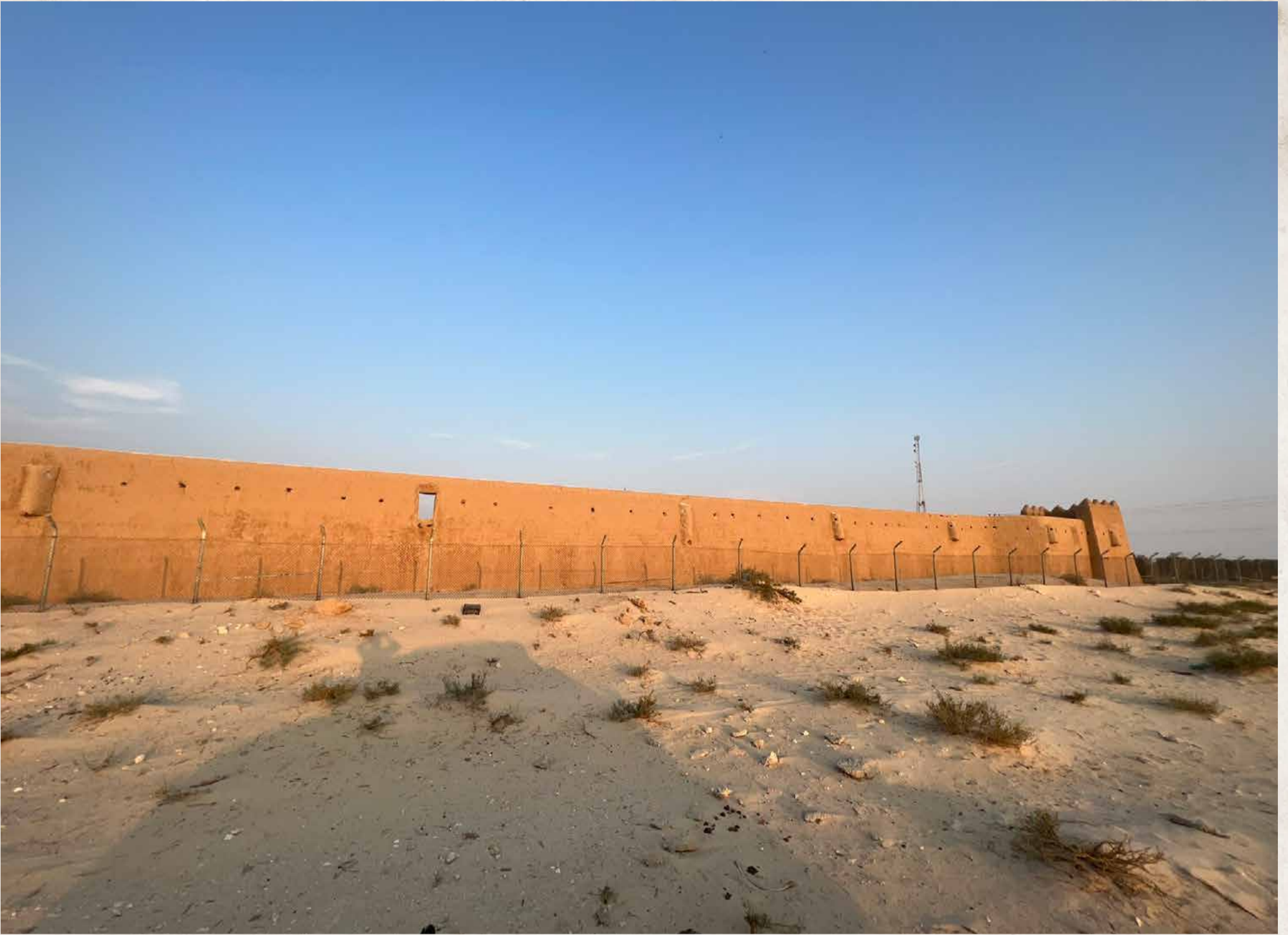
قصر الملك عبد العزيز بنطاع - المنطقة الشرقية أثناء الترميم
