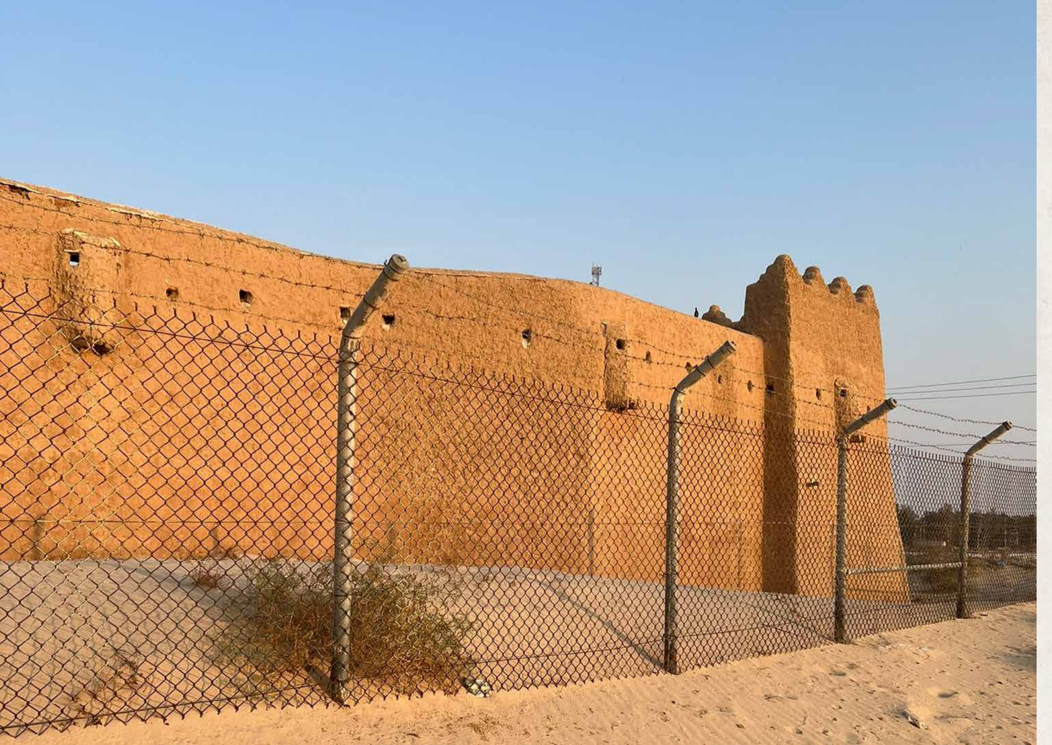
قصر الملك عبد العزيز بنطاع - المنطقة الشرقية أثناء الترميم
