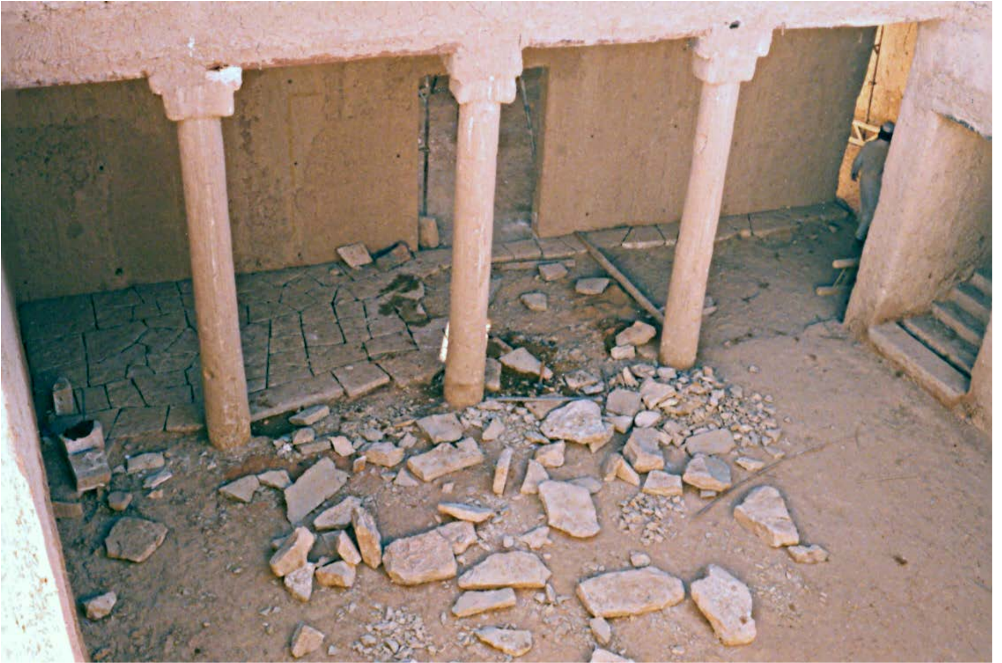
بيت نخل العذيبات أثناء الترميم
