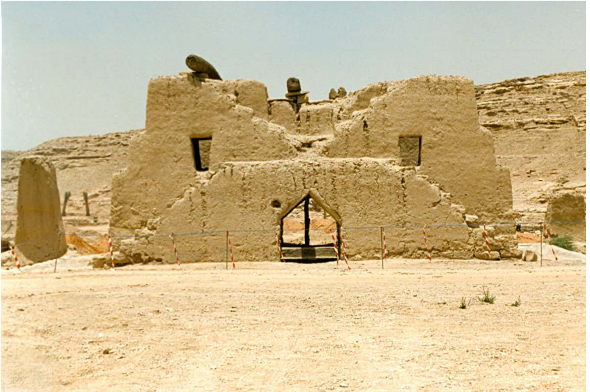
البئر الكبرى قبل الترميم
