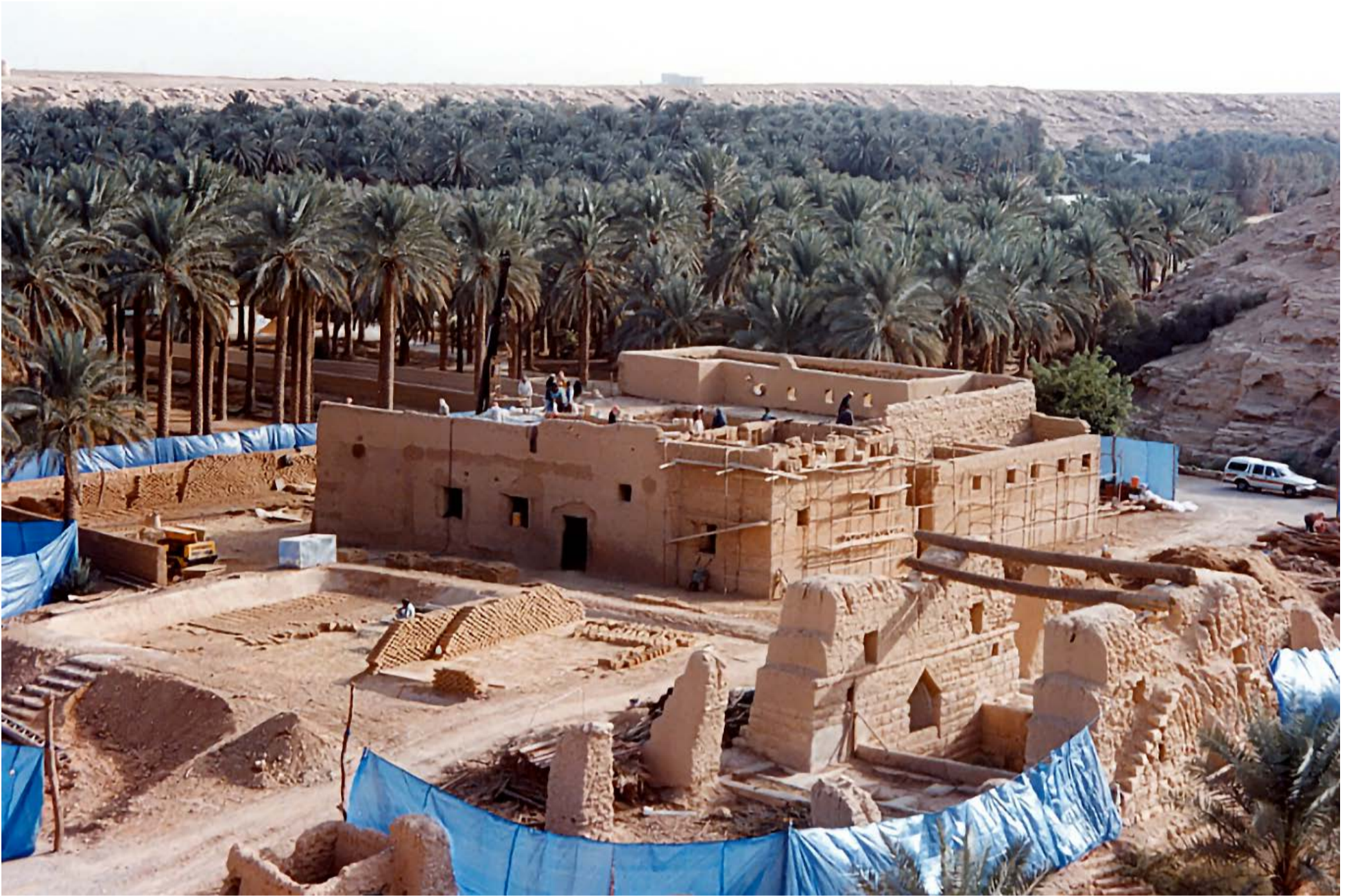
بيت نخل العذيبات أثناء الترميم
