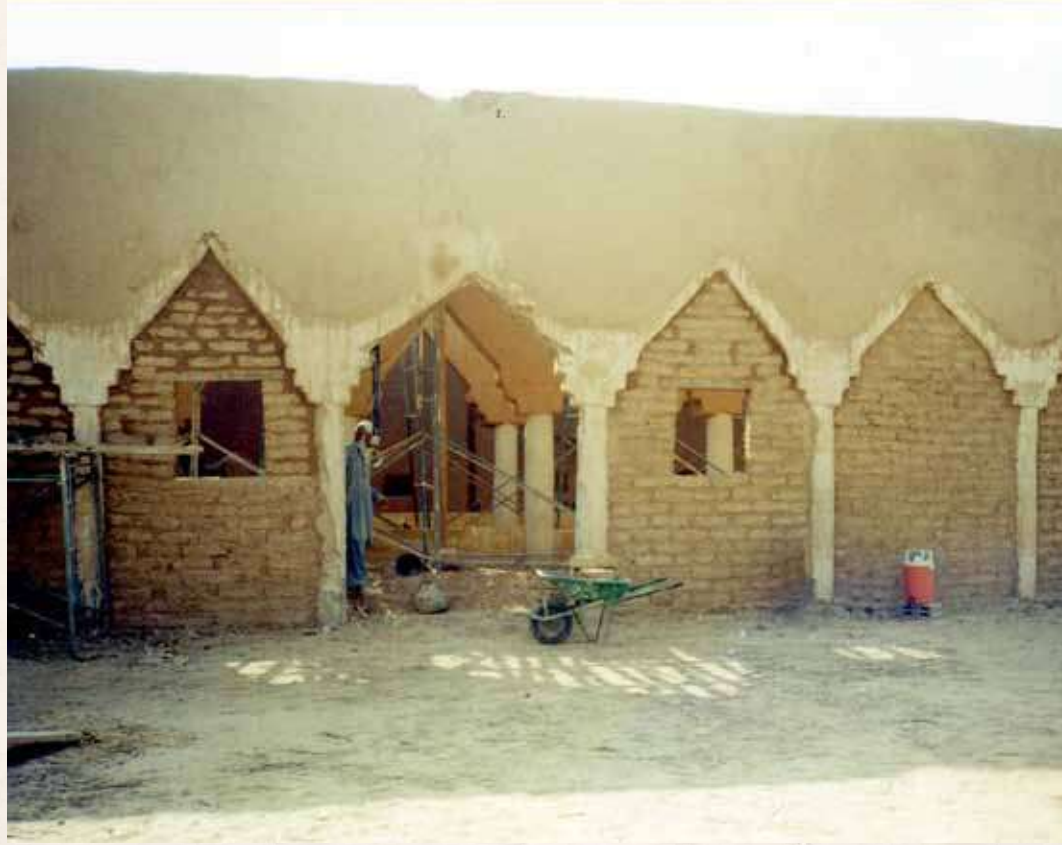
فناء مسجد الرملية في أثناء الترميم
