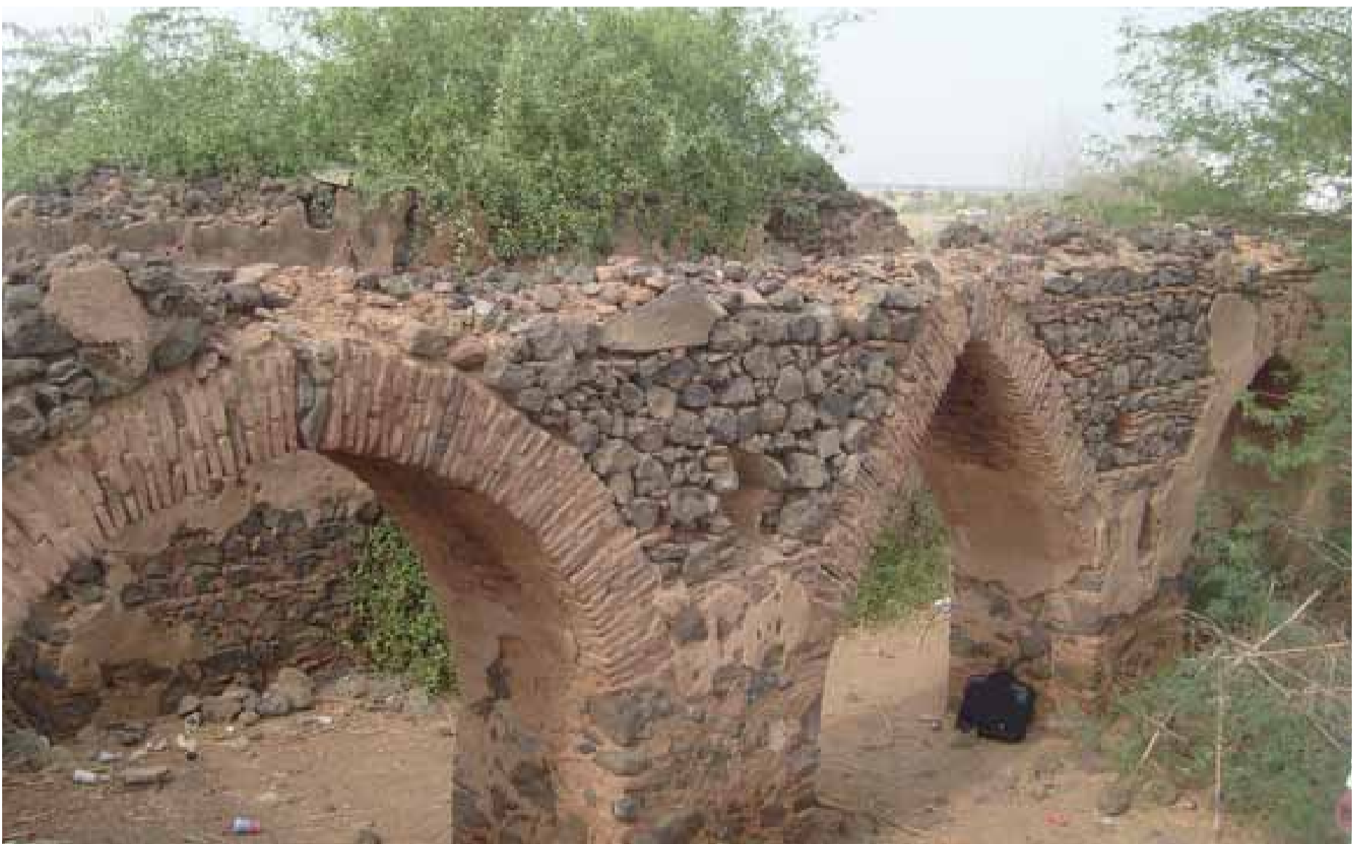
مسجد الحسيني - العقود المتبقية قبل الترميم - شقراء
