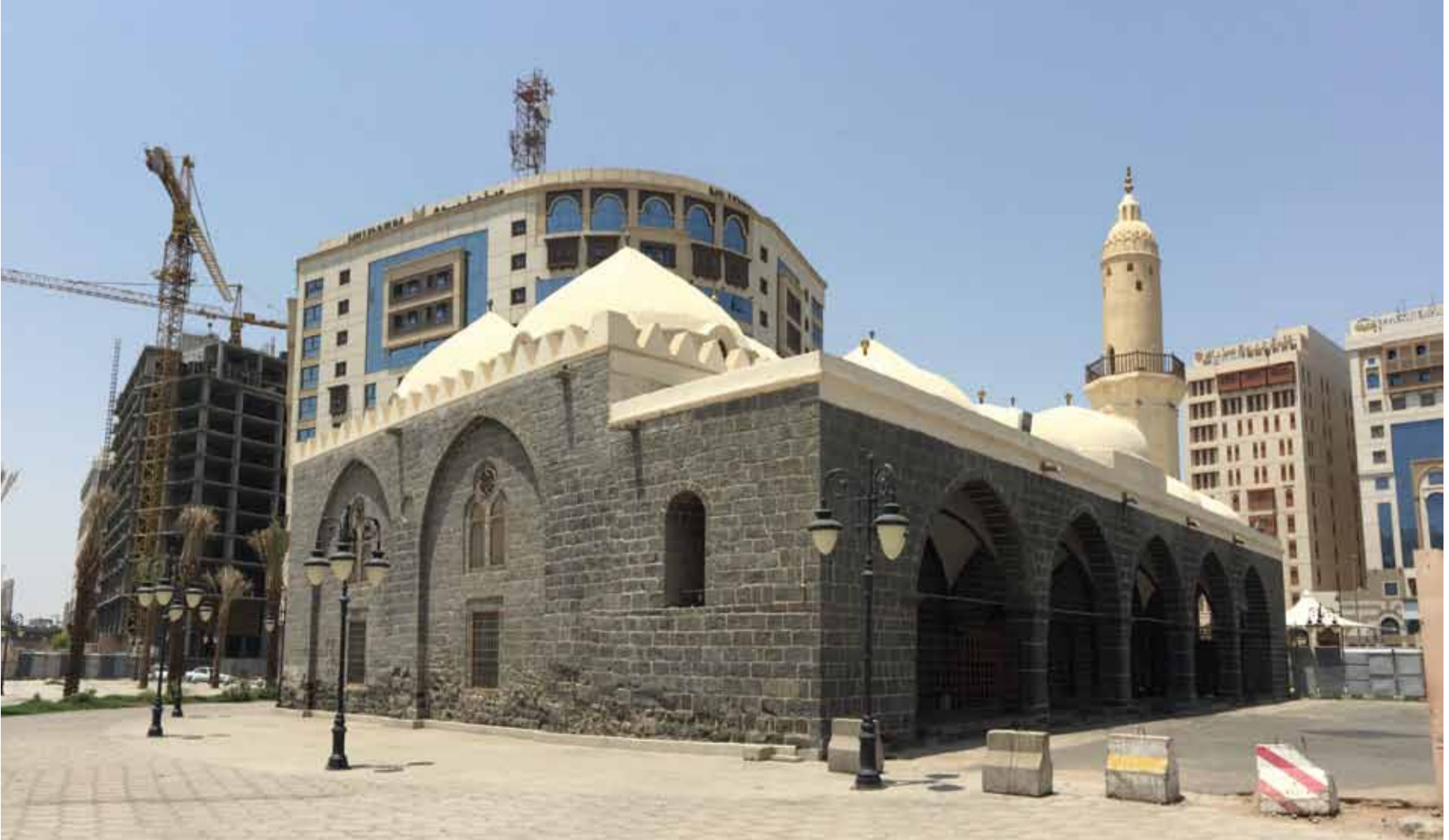
مسجد الغمامة بعد الترميم، سنة ١٤٣١هـ (٢٠١٠م) - المدينة المنورة
