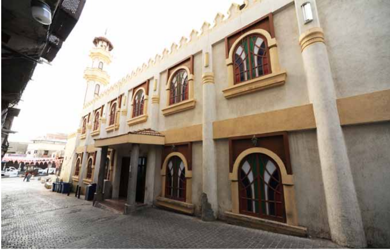
مسجد المغربي قبل الترميم - جدة التاريخية
