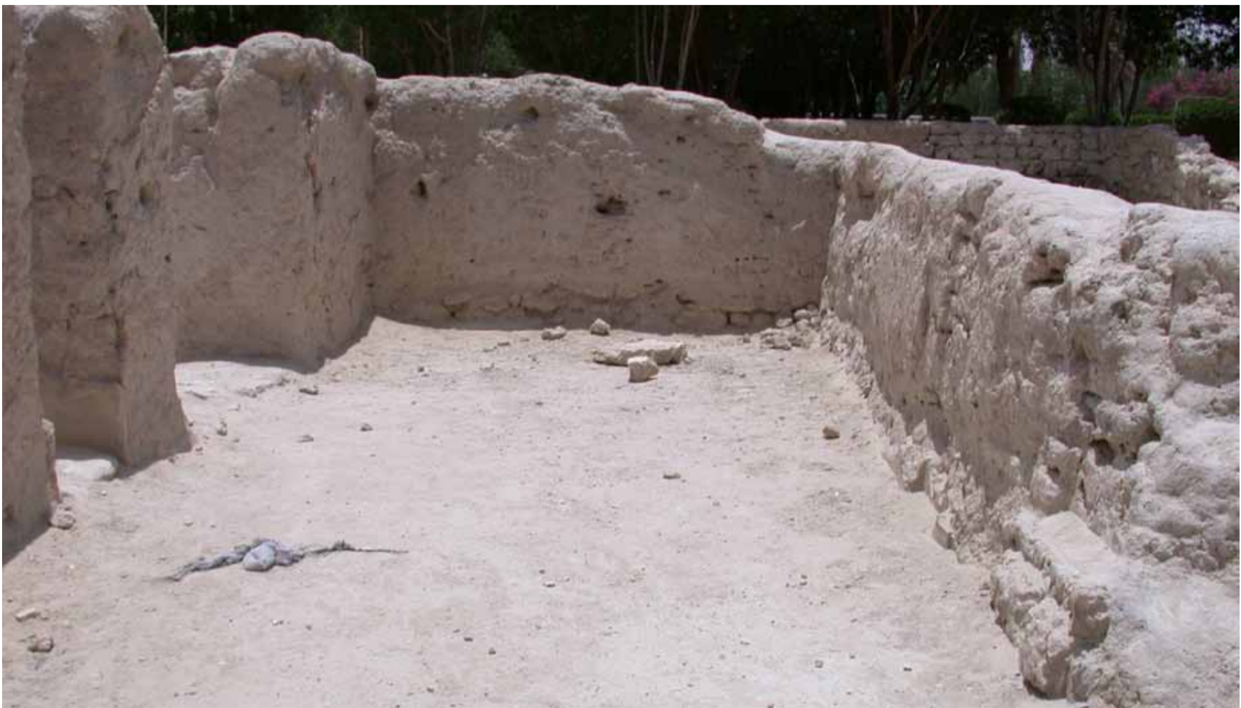
مسجد الجواثا قبل الترميم - الأحساء
