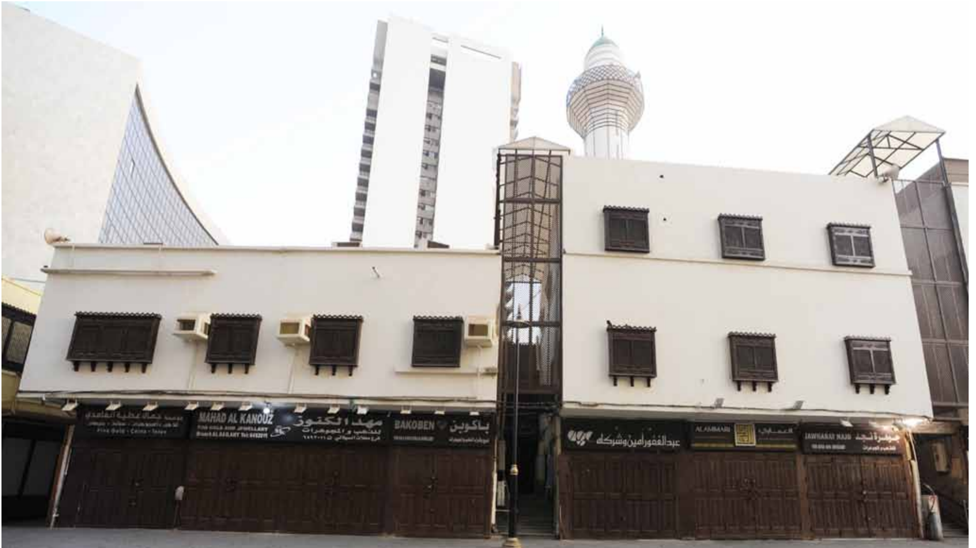
مسجد عكاش قبل الترميم - جدة التاريخية
