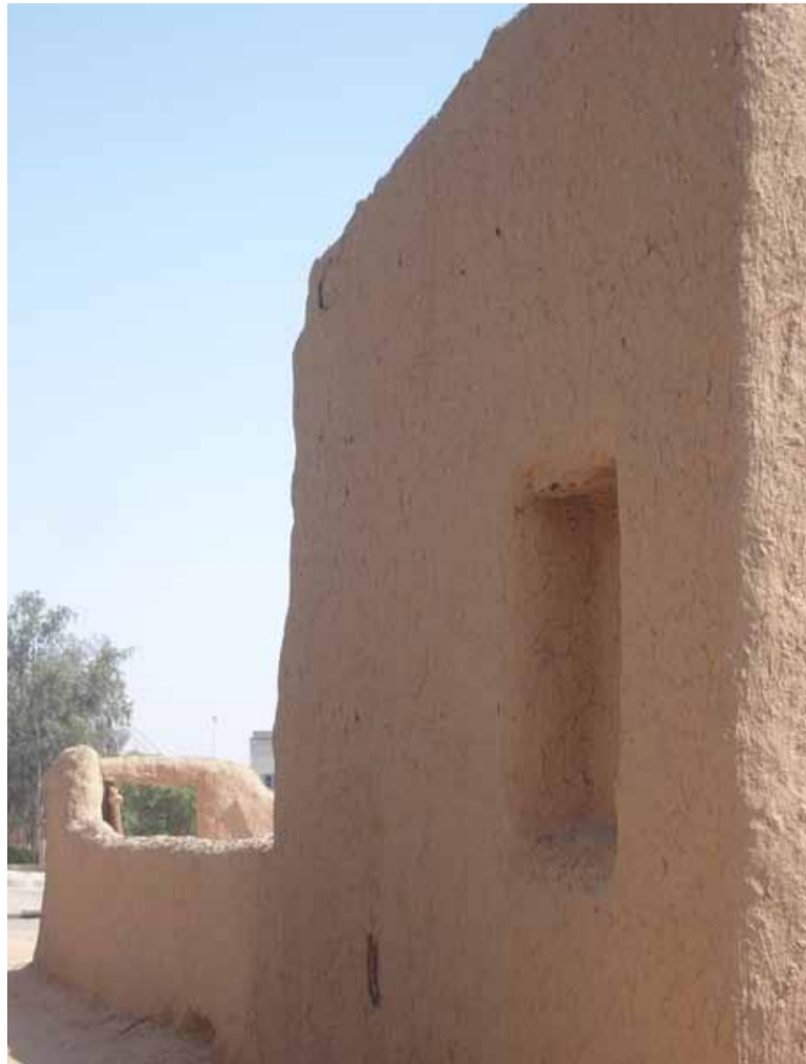
الواجهة الجانبية لمسجد قراشة قبل الترميم - حرملاء
