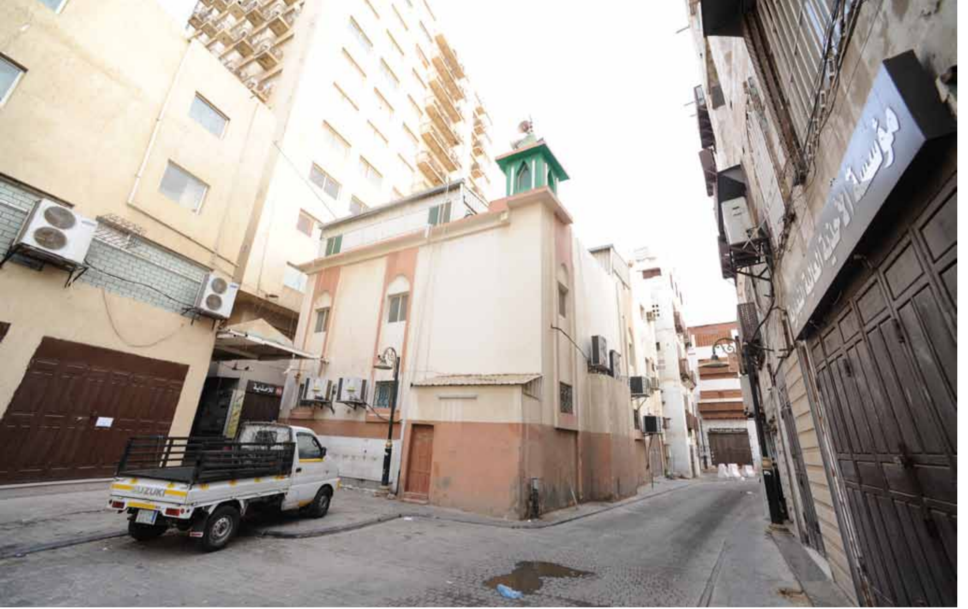
مسجد الفتن قبل الترميم - جدة التاريخية
