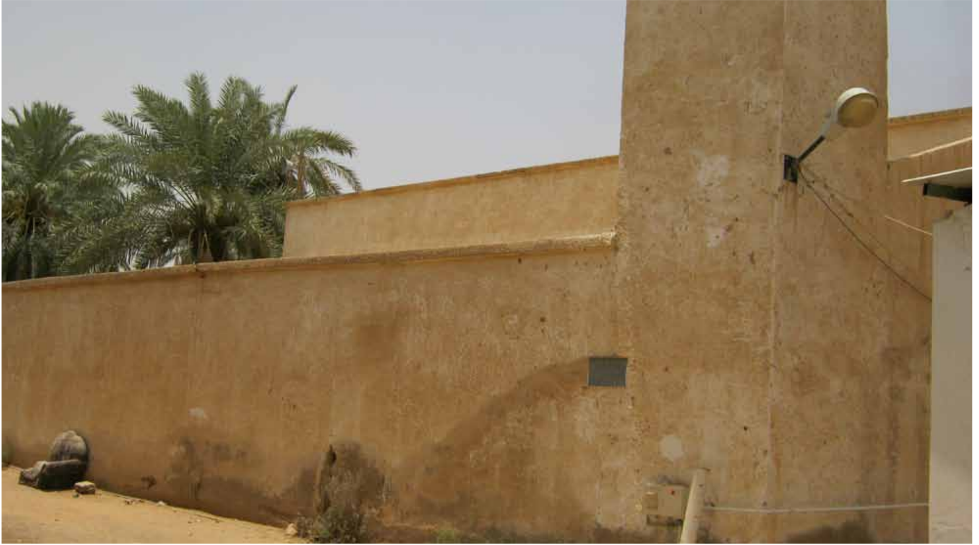
مسجد المربح قبل الترميم - الدرعية التاريخية
