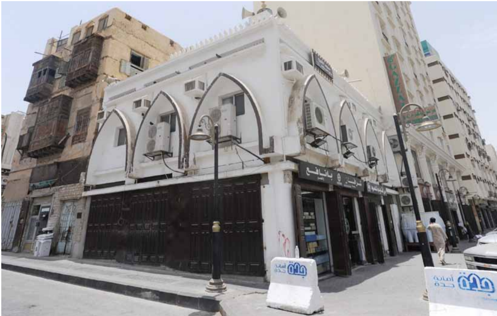
مسجد غلوم قبل الترميم - جدة التاريخية
