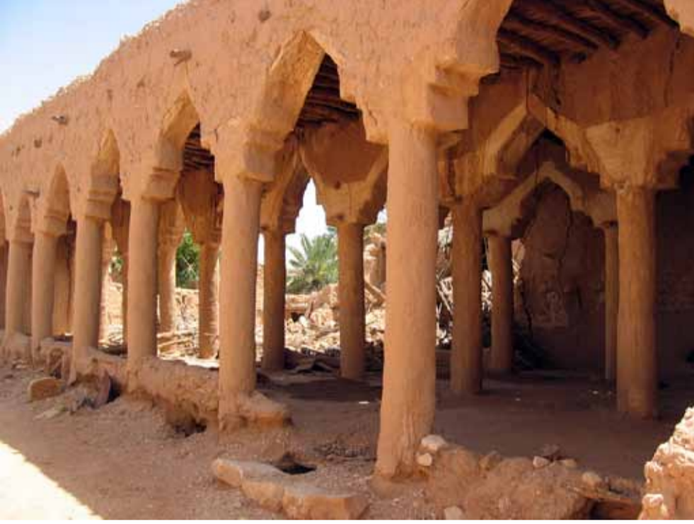
مسجد العوشة قبل الترميم - الغاط
