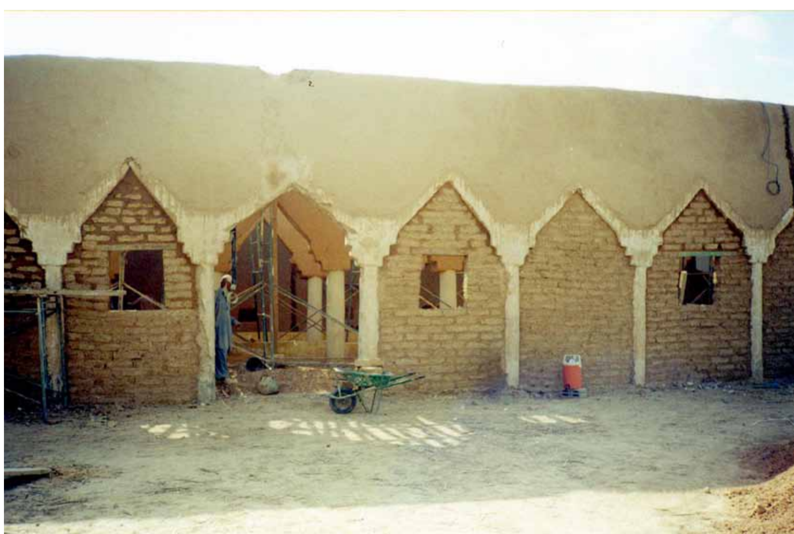
مسجد الرميطة في أثناء الترميم - الرياض
